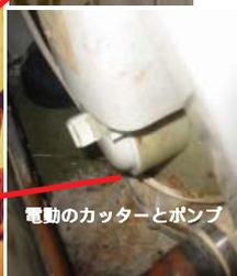
日本にも地下室用にポンプと糞砕カッターを内蔵し、高さ4mまで強制的に圧送排水する圧送トイレという商品がある。
