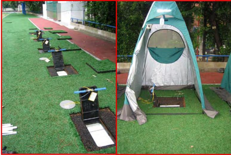
このマンホール式トイレを災害時の指定避難所に設置していざという時の備えを行政で実行している自治体がある。東京渋谷区である。区内 32 ケ所（小学校 15、中学校 8 校、他 9 ケ所）の校庭の人工芝等の下に 1 ケ所 10 のマンホールを設置し、プライバシー確保用品を校内にある災害用倉庫に準備したという。下水道直結の流下型トイレで汚水を利用したり、プールの水も利用という。
