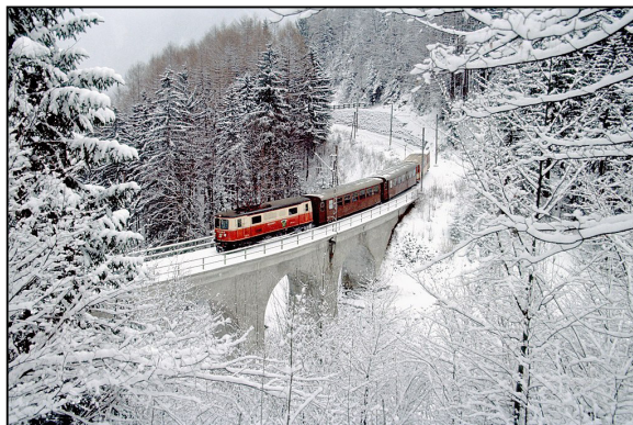
ホイグラーベン高架橋
